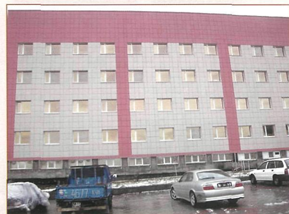
Начаты работы по реконструкции цокольных помещений и благоустройству прилегающей территории (2007 год).
