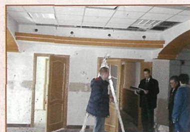
Начаты работы по реконструкции помещений, частично выполнены отделочные работы (2006-2007 г.).
