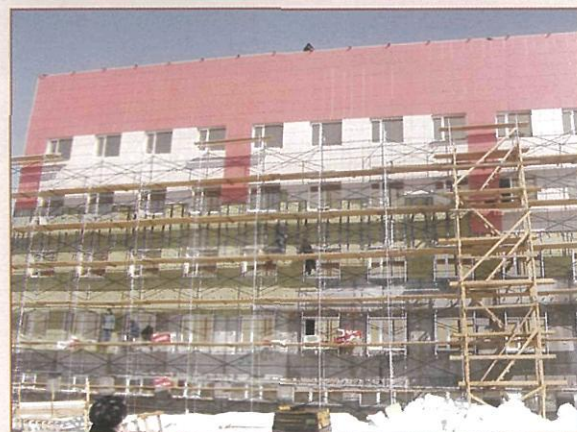
Проводятся работы по отделке фасада здания (2006 год).
